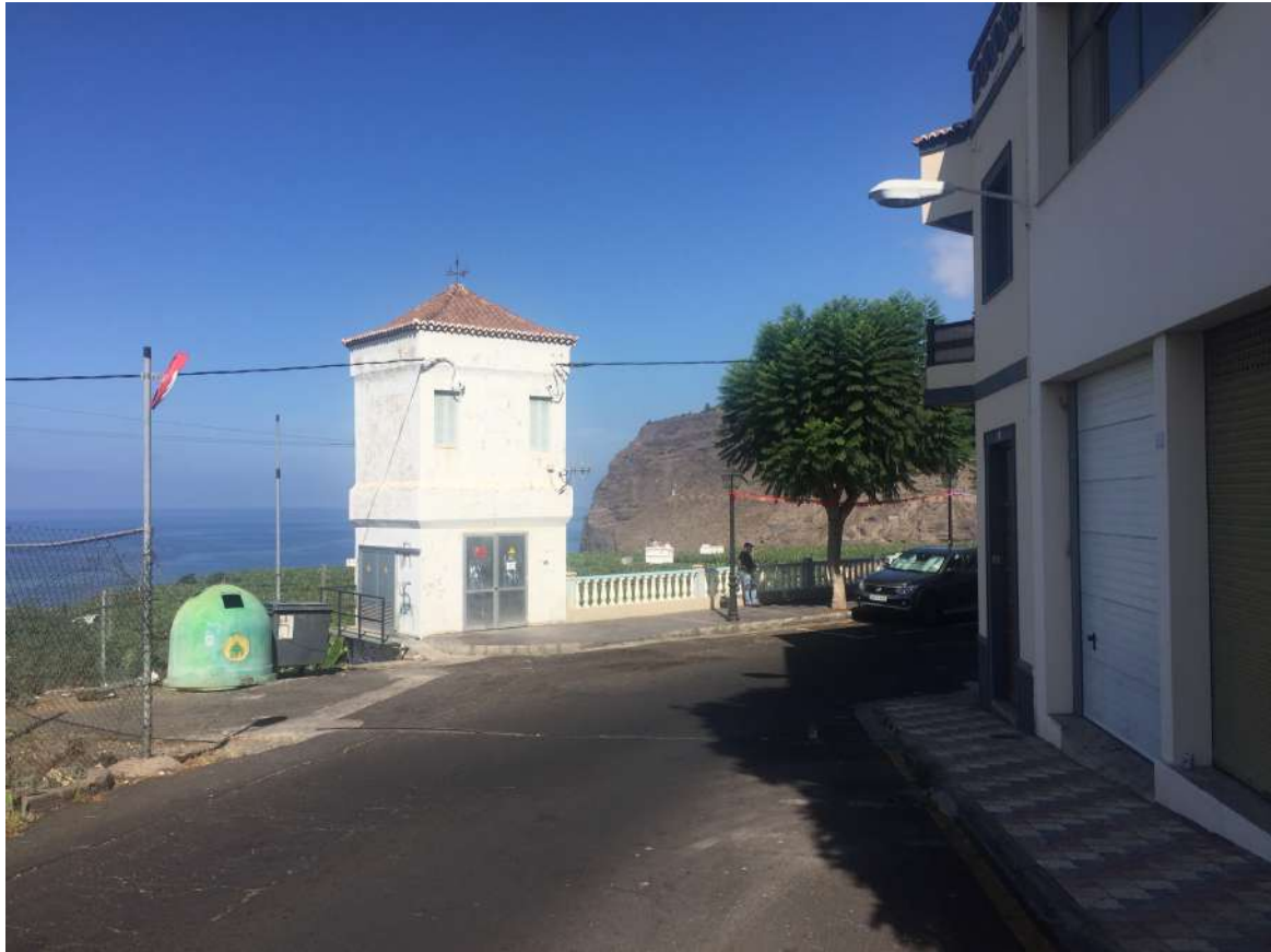
Torreón eléctrico. Límite de la intervención al sur
