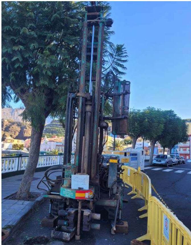
Foto 1: Perforadora TP-50D instalada en el sondeo S-1
