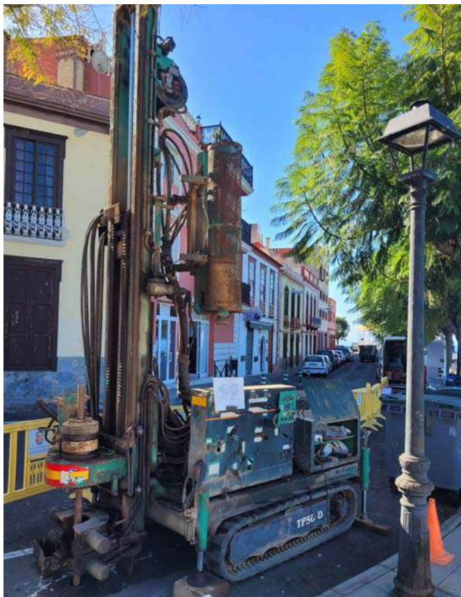
Foto 6: S Perforadora TP-50D instalada en el sondeo S-2
